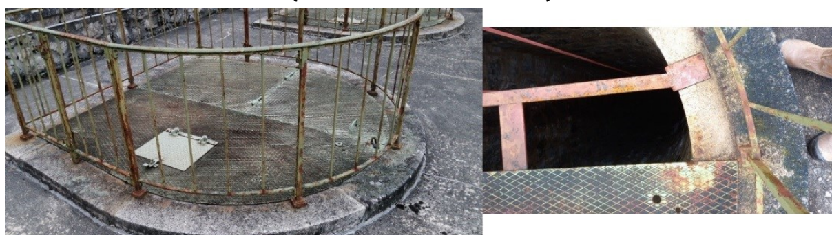
Support et plaques de fermeture des puits présentant des signes d'usure (Photos DDT58 et EGIS)
