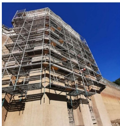
L'échafaudage et la bâche de protection
