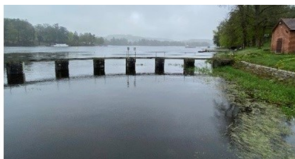
Evacuateur de crues (zone amont) (Photos DDT 58)
