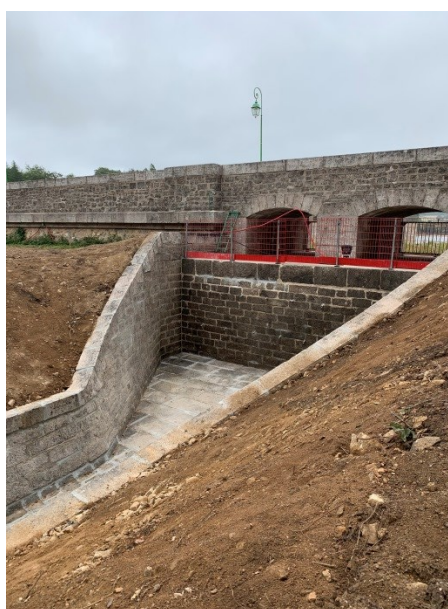
Coursier évacuateur de crues pendant et après travaux (3 première photos DDT 58)
