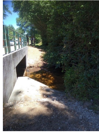
Réalisation d'une « banquette Loutre » sous le pont de l'Arpan, Entrée de la Cure dans les Settons (Gauche, côté Amont, Droite côté Aval) (Photos DDT58)
