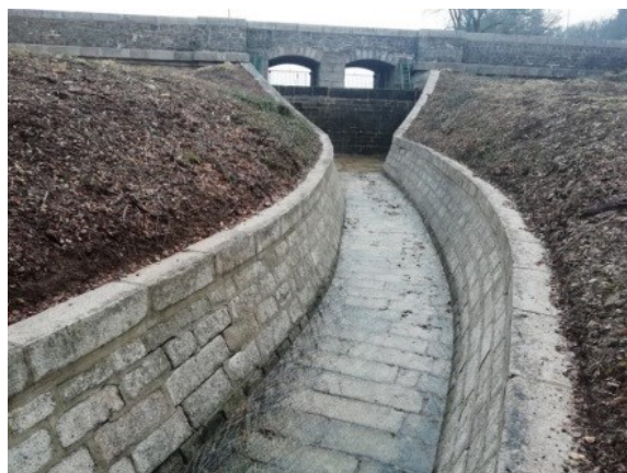
Coursier évacuateur de crues avant travaux (Photos DDT 58)
