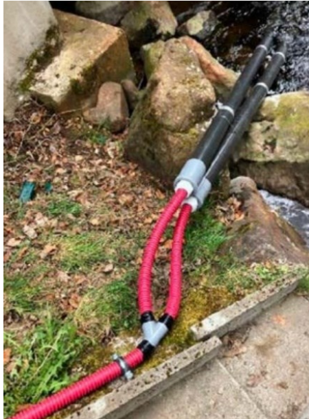
Connection provisoire d'une station Photo DDT 58
