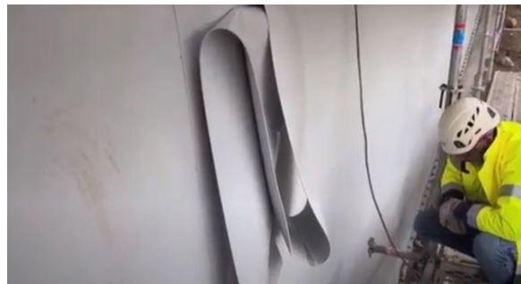
Détails de la pose de la géomembrane sur Les Settons
