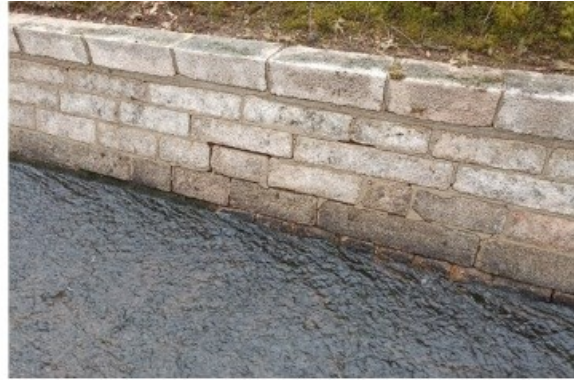
Coursier épanchoir 3 (Photos DDT 58)
