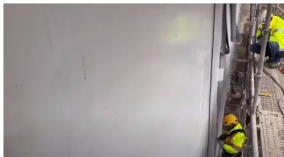
Détails de la pose de la géomembrane sur Les Settons
