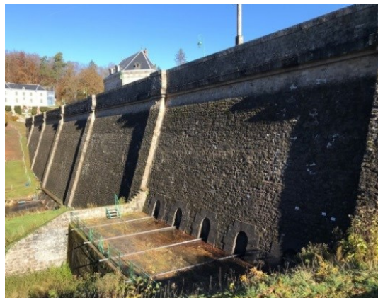
La digue primitive et le masque de Lévy, le parement aval (Photos DDT 58)
