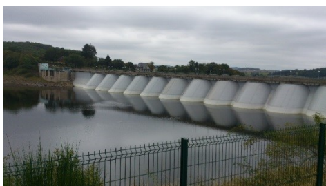
Le barrage de Pannecière recouvert de sa géomembrane en 2011
