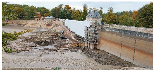
L'échafaudage et la bâche de protection
