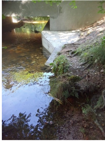
Réalisation d'une « banquette Loutre » sous le pont de l'Arpan, Entrée de la Cure dans les Settons (Gauche, côté Amont, Droite côté Aval) (Photos DDT58)
