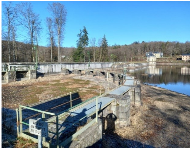
Garde-corps, passerelles et portillon de l'entonnement de l'EVC (Photos DDT58 et EGIS)
