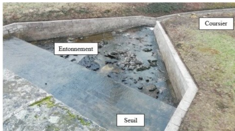
Seuil épanchoir n°3 (Photo DDT 58)
