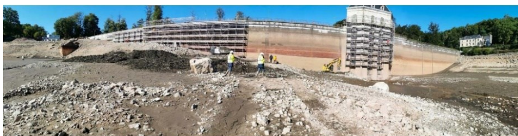
Vue panoramique du chantier (Photo DDT 58)
