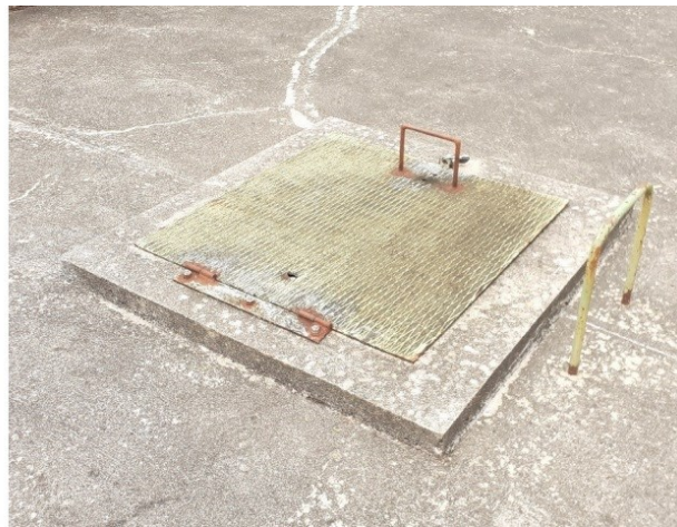
Echelles et trappe d'accès aux chambres en béton du masque Levy (Photos DDT58 et EGIS)
