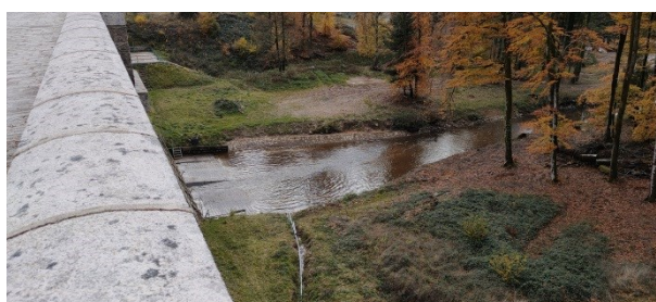
Travaux achevés au 15/11/2023
