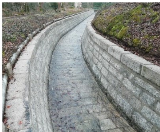
Coursier évacuateur de crues avant travaux (Photos DDT 58)
