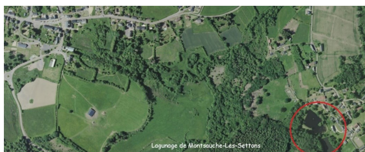
Le lagunage de Montsauche-Les-Settons
