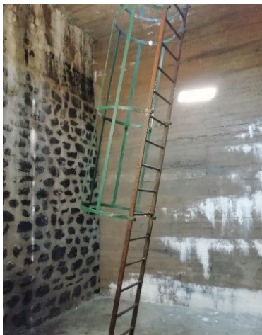
Echelles et trappe d'accès aux chambres en béton du masque Levy (Photos DDT58 et EGIS)
