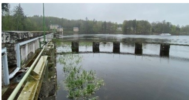
Evacuateur de crues (zone amont) (Photos DDT 58)
