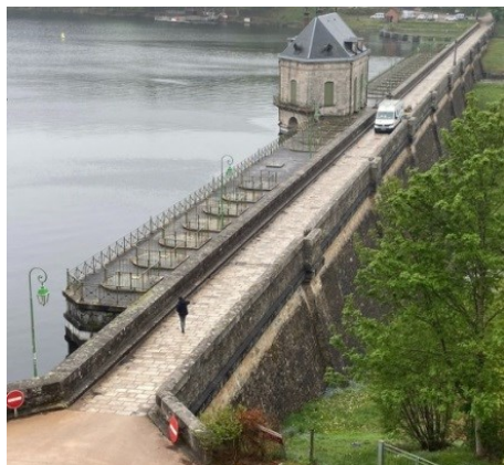
La digue primitive et le masque de Lévy, le parement aval (Photos DDT 58)
