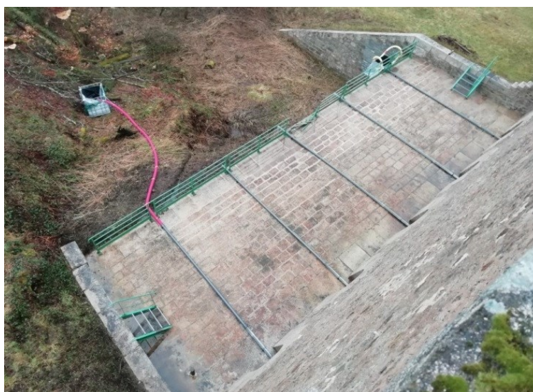
Epanchoir n°2 (aval) (Photos DDT 58)
